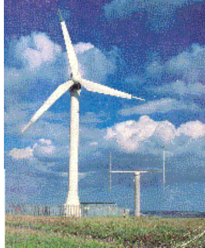
3-сурет. Эксперименттік жел қондырғысы (Англия): а) Үш қалақшалы пропеллерлі жел турбинасы; б) Тік қалақшалы Дарье жел турбинасы.
